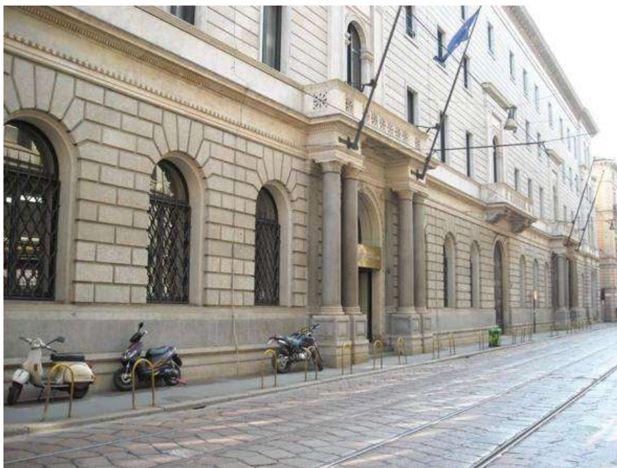
Figura 1 - Palazzo Turati, via Meravigli
